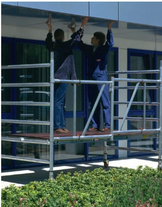
La série 5500 permet de composer un échafaudage pliant large, avec un plancher constitué de deux plates-formes.
